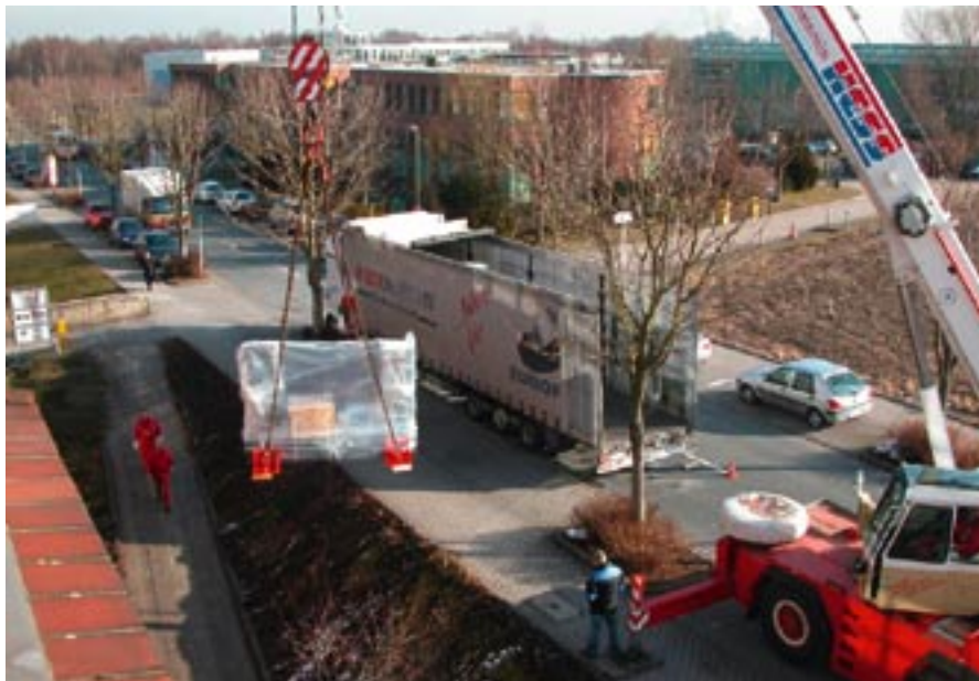
ANLIEFERUNG DES CA. 5 TONNEN SCHWEREN MANIPULATORS AM 14. MÄRZ DIESEN JAHRES.
